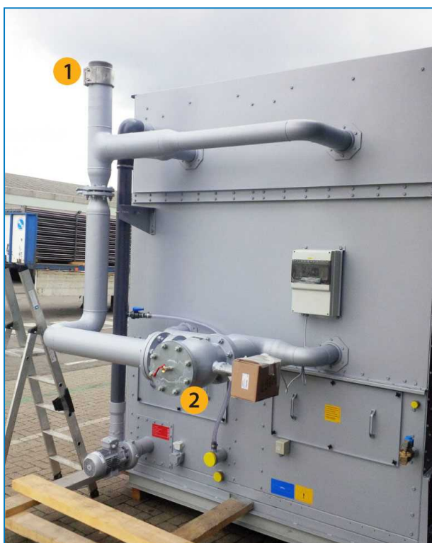
Jednotka s uzavretým vonkajším potrubím
