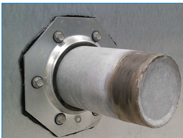
Spodné uzavreté spojenie výmenníka (na chladiacich vežiach s uzavretým obvodom s pripojením do ND100).
