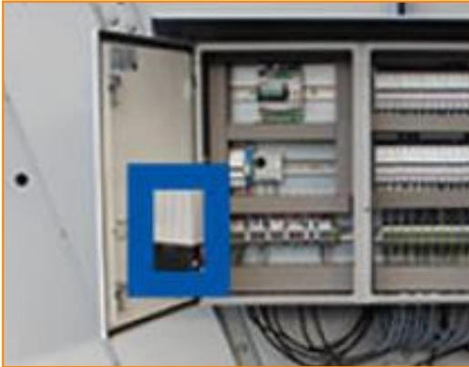
Protege los componentes electrónicos del panel eléctrico con temperaturas frías extremas.
