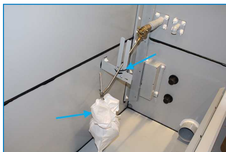
Fastsättning och lindning av flottörkula
