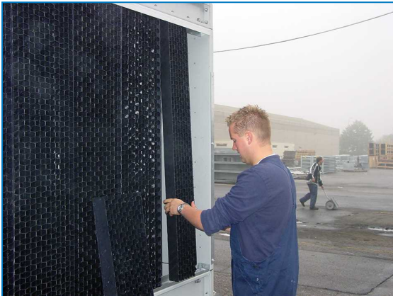
Demontering av kombinerade inloppspaneler
