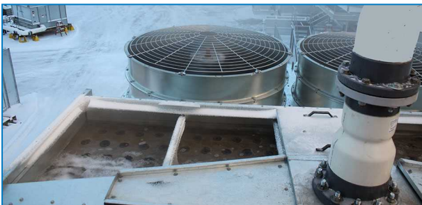
Varmvattenbassäng och distributionsbassängskydd
