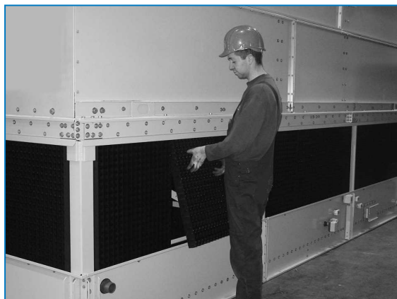
Demontering av kombinerade inloppspaneler
