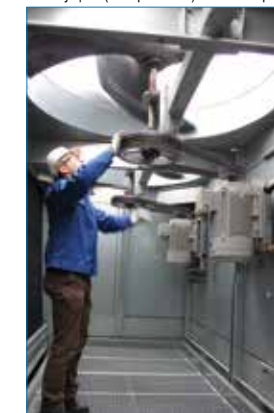
Система привода вентилятора легко доступна при стоянии
