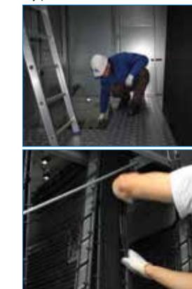
Запатентованный наполнитель ВАСcross, обеспечивающий легкий осмотр и очистку лист за листом
