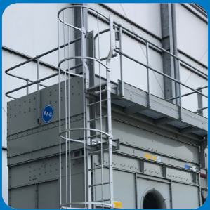
Uitwendig onderhoudsplatform, ladder & omheining
