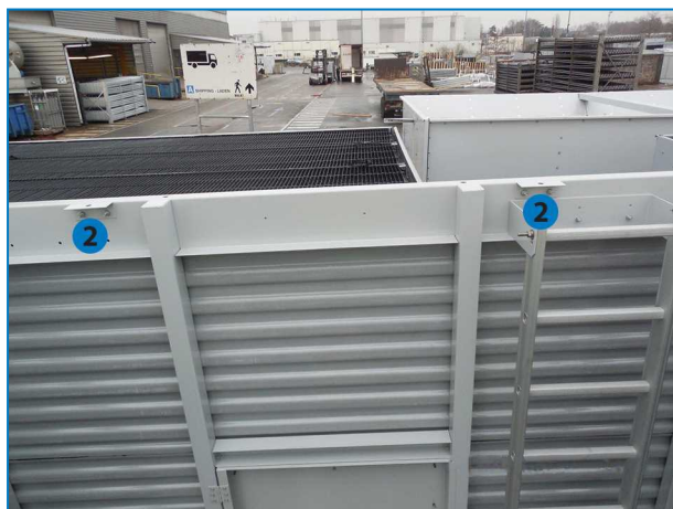
2. Prowadnica/wspornik montażowy dolnej sekcji
