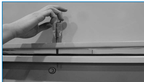
Zastosowanie kołków ustalających do osiowania otworów śrub
