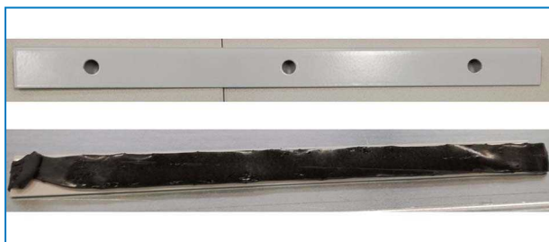
Zaptivanje profila pomoću butil trake za zaptivanje
