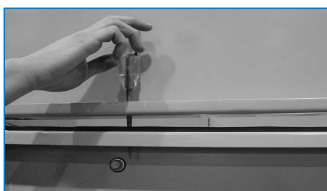
Korišćenje osovinice za poravnanje rupa sa navojima
