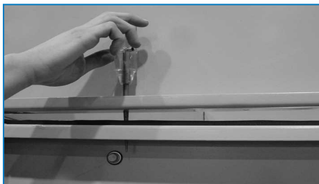
Korišćenje osovinice za poravnanje rupa sa navojima
