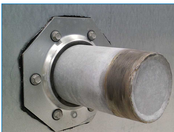
Donji zatvoreni priključak izmenjivača (na zatvorenim rashladnim kulama sa priključcima veličine do ND100).
