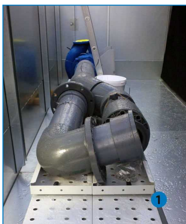
1. Uklonite pumpu i cevi iz bazena.
