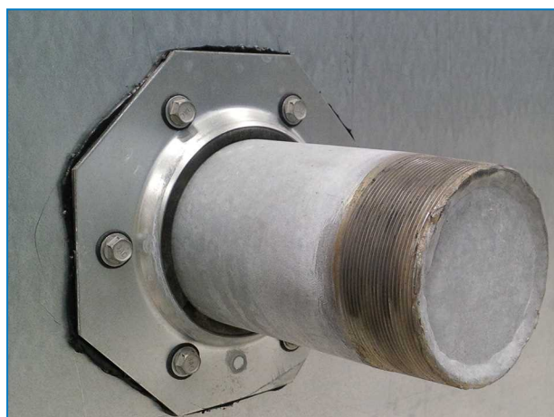
Onderste afgesloten batterijaansluiting (op koeltorens met gesloten kringloop met aansluitingen tot ND100).
