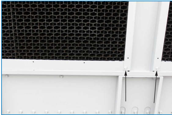
Uklanjanje transportnih traka za osiguranje tereta
