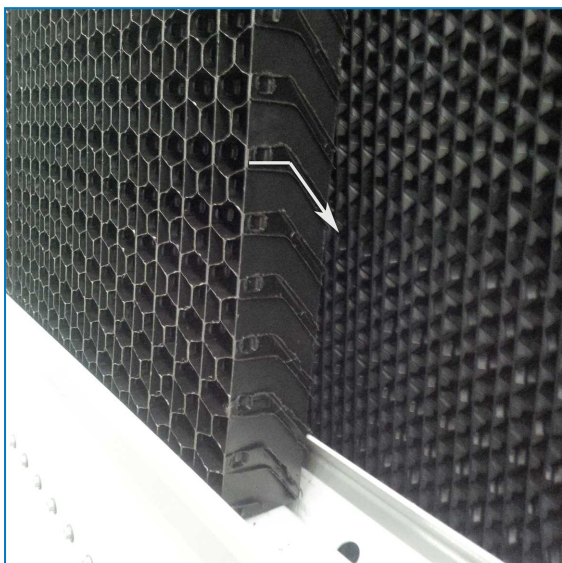
Orijentacija kombinovanih zaštitnih ulaznih rešetki
