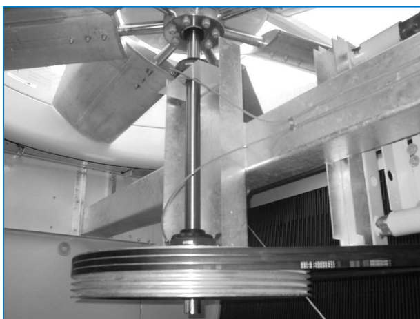
Osovina ventilatora
