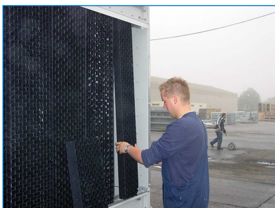
Uklonite kombinovane zaštitne rešetke ulaznog otvora
