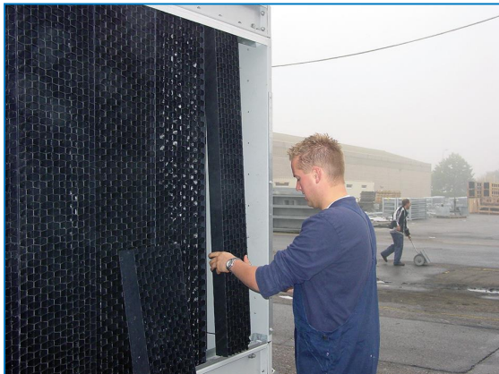
Uklonite kombinovane zaštitne rešetke ulaznog otvora
