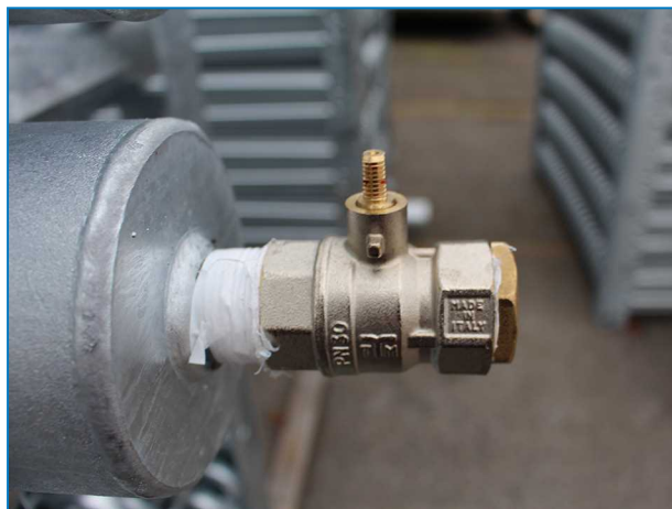
Övre slingkoppling med övertrycksventil på kondensorer.
