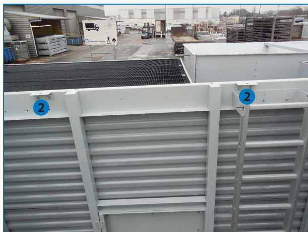
2. Suporte/guia de amarração da secção inferior
