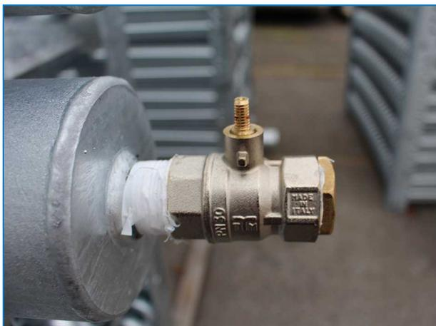
*Ligação da serpentina superior com válvula de alívio de pressão nos condensadores.*
