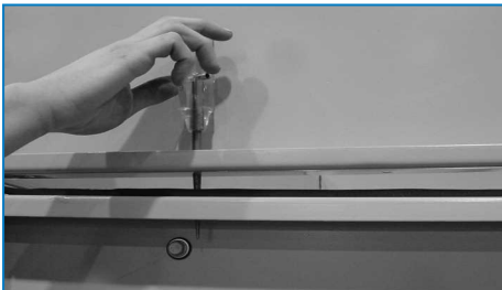
Utilização de pinos provisórios para alinhar os orifícios de fixação
