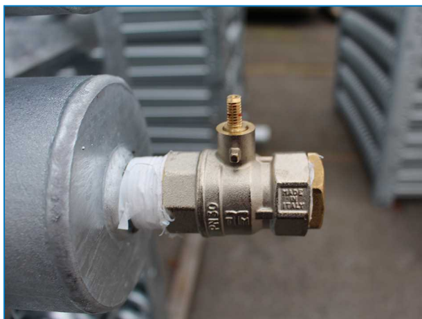
Attacco batteria non bobine con valvola limitatrice di pressione sulle torri di raffreddamento a circuito chiuso con attacchi fino a DN 100.
