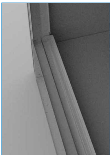
Canalón de recogida de agua
