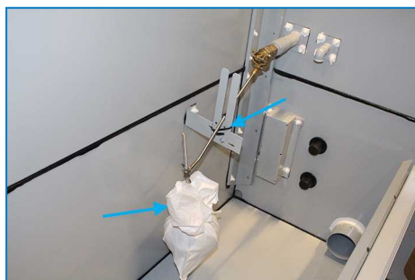
Montaż i owijanie kuli pływaka
