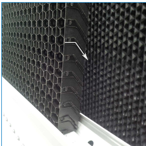
Orientacja zespolonej osłony wylotowej
