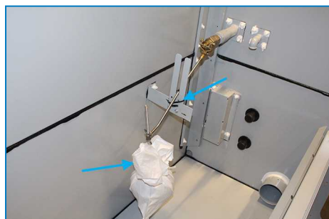
Montaż i owijanie kuli pływaka
