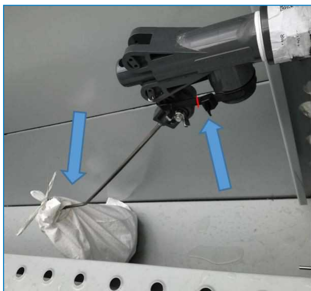
Montaż i owijanie kuli pływaka
