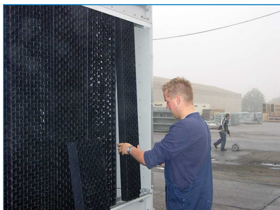
Usuwanie zespolonych osłon wlotowych
