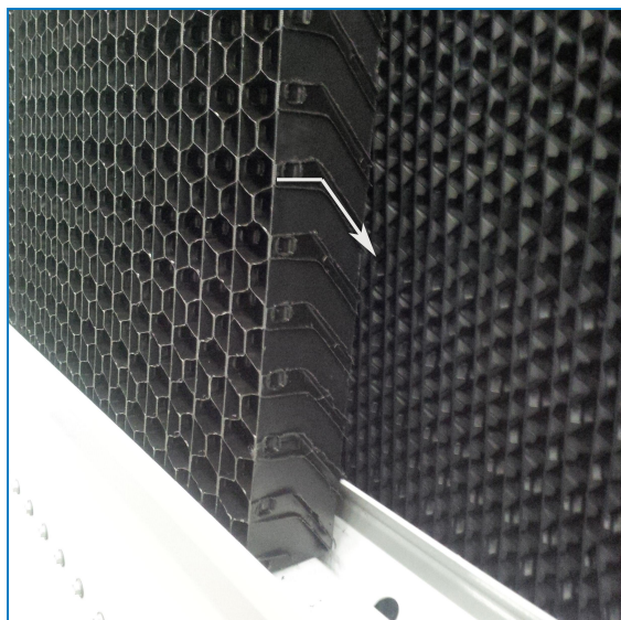
Orientacja zespolonej osłony wylotowej
