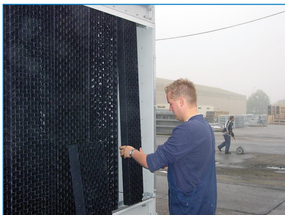
Usuwanie zespolonych osłon wlotowych
