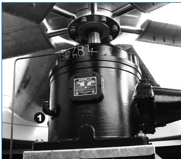
Napęd zębaty z pojedynczym przełożeniem
