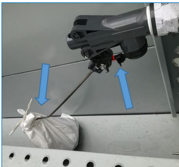
Montaż i owijanie kuli pływaka
