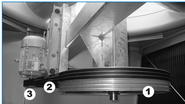
Przekładnia napędowa
