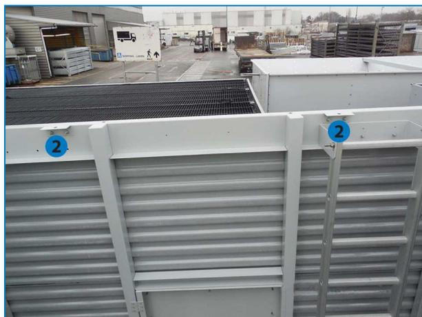
2. Guida/staffa per il montaggio della sezione inferiore
