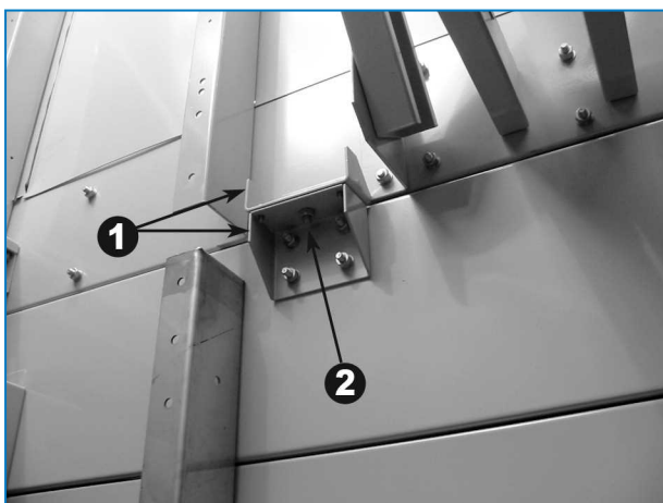
Sezione plenum installata su sezione inferiore
