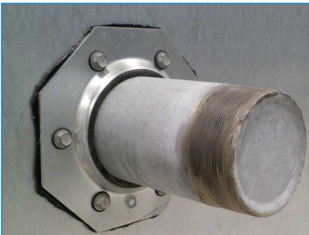
Alsó lezárt csökköteg-csatlakozás nyomásmentesítő szeleppel (zárt áramkörű hűtőtornyokban, az ND100-hoz való csatlakozással).
