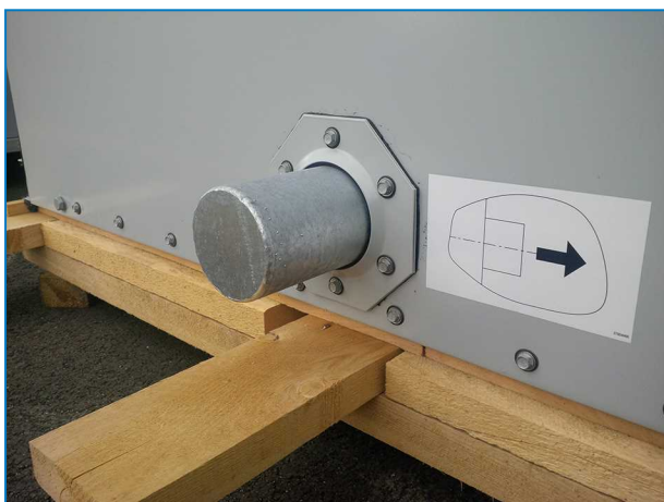
Alsó lezárt csőköteg-csatlakozás nyomásmentesítő szeleppel evaporatív kondenzátorok.
