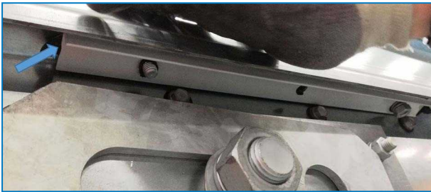
Beszerelt tömítőprofil
