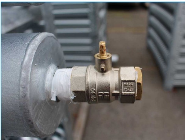
Nicht-Gewinde Rohrbündelanschluss mit Druckentlastungsventil auf Eisspeicher Gerät für Direktkältemittelzufuhr.
