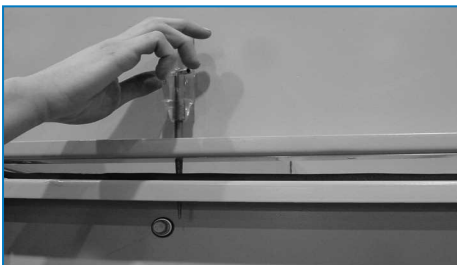
Verwendung des Treibdorns zur Ausrichtung der Schraublöcher
