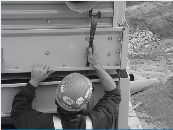
Eckausrichtung mit Treibdorn
