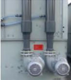
Dispositif thermoplongeur      Pompe de réserve
