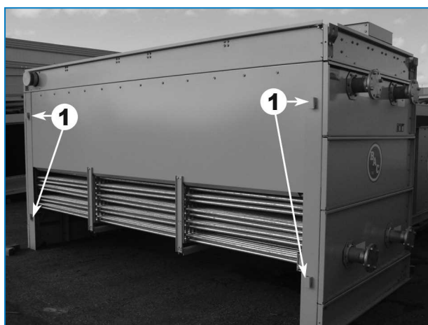
Монтажные направляющие с выступами на секции теплообменника
