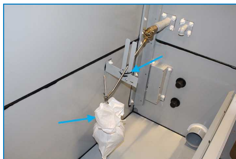
Upevnění a zabalení kulového plováku
