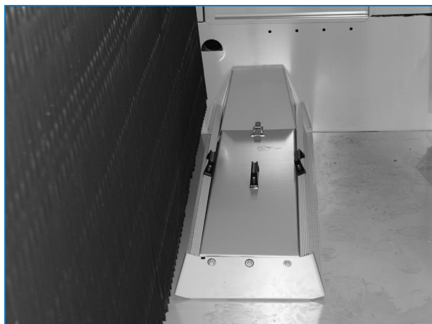
Бассейн холодной воды и сетчатый фильтр бассейна
