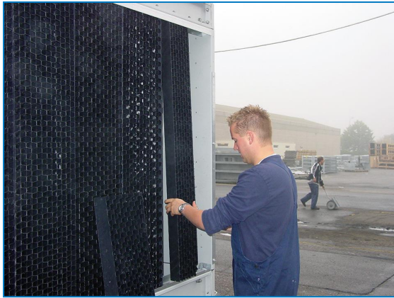
Снятие комбинированных щитов на входе
