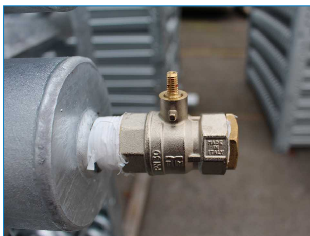
Соединение верхнего теплообменника с клапаном, стравливающим давление, на закрытых градирнях с соединениями больше, чем ND100.
