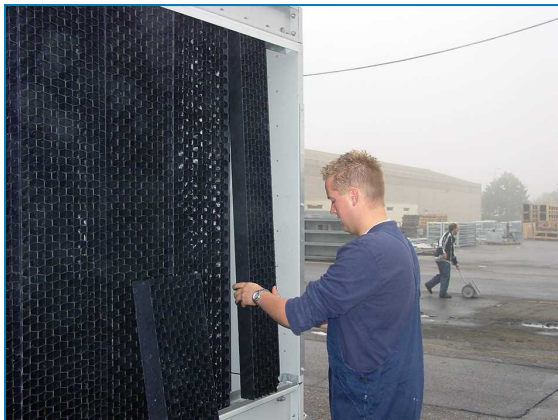
Odstránenie kombinovaných krytov nasávania
