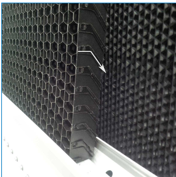
Orientácia kombinovaného krytu nasávania
