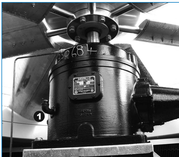
Prevodový pohon s jednoduchou redukcíou
