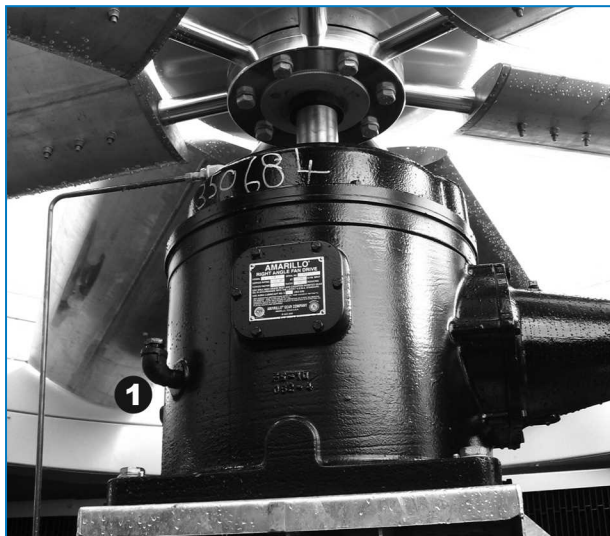
Prevodový pohon s jednoduchou redukciou
