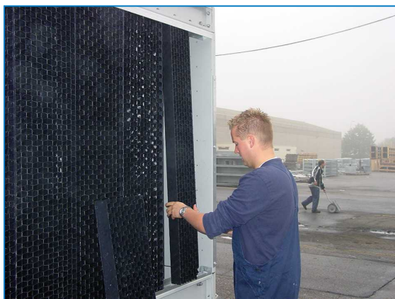
Odstránenie kombinovaných krytov nasávania
