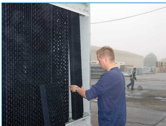
Demontáž kombinovaných krytů sání vzduchu
