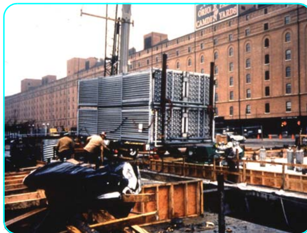
Установка змеевиков в бетонный резервуар
