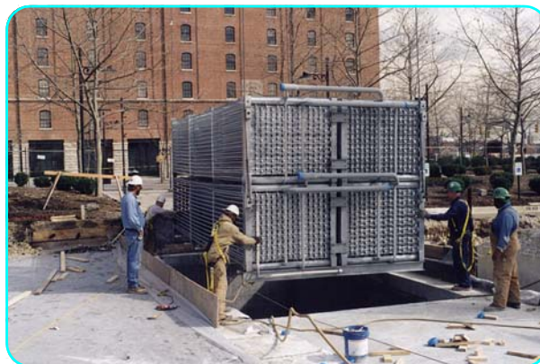
Монтаж модуля змеевика
