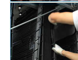
Gepatenteerd BACross-vulpakket voor inspectie en reiniging blad per blad
