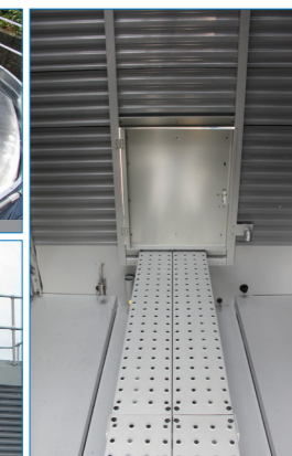
Naar binnen scharnierend toegangsluik en ingebouwde loopbrug*
