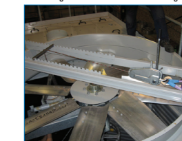
Demontage van mechanische uitrusting*
