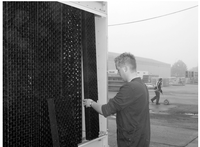
15. Rysunek : Usunąć zespolone osłony wlotowe
