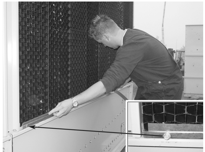
14. Rysunek : Usuwanie pasów zabezpieczających
