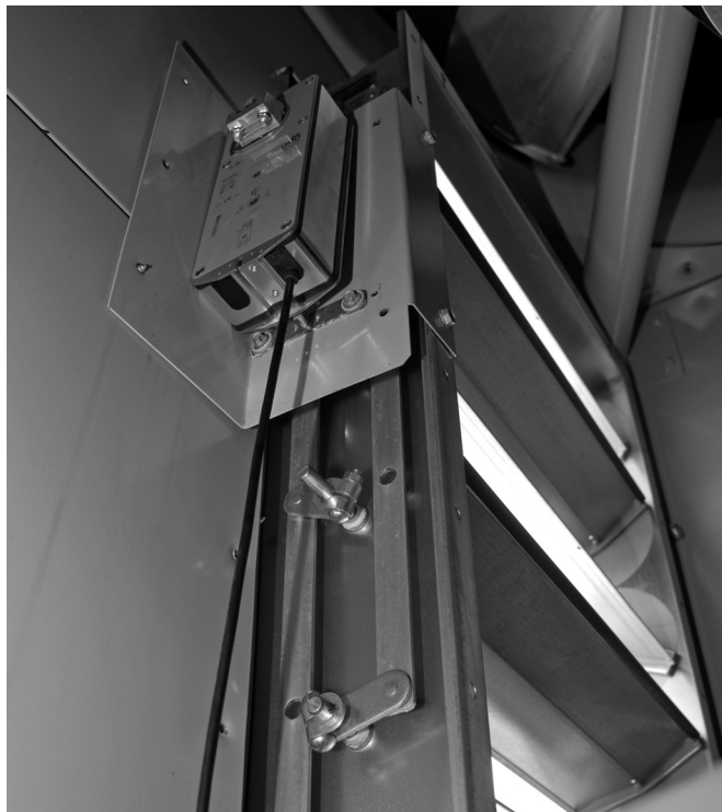
12. Rysunek : Siłownik modułowych zasuw wlotu powietrza
