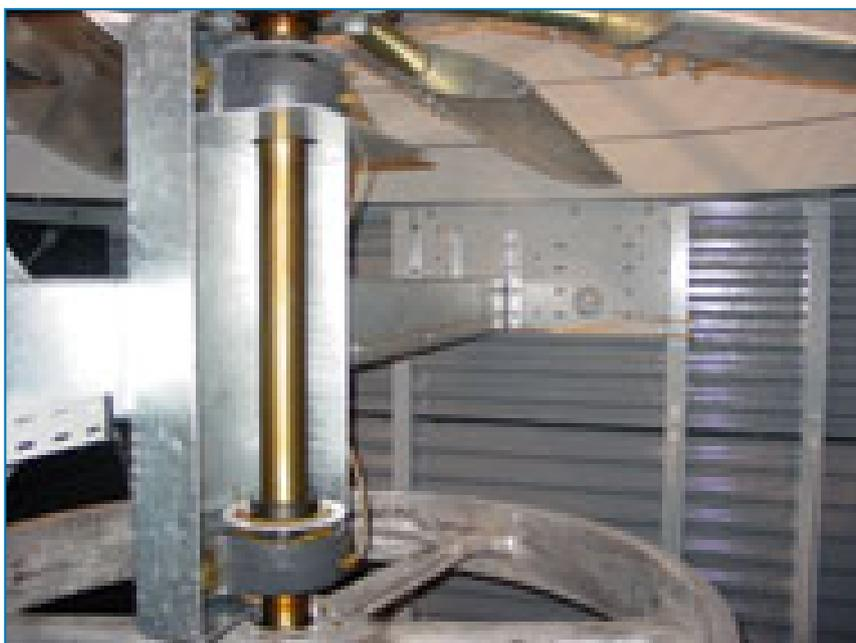
Для смазки подшипников вала вентилятора могут быть использованы удлиненные смазочные линии со смазочными фитингами. Фитинги расположены внутри плenums рядом с дверцей люка.
