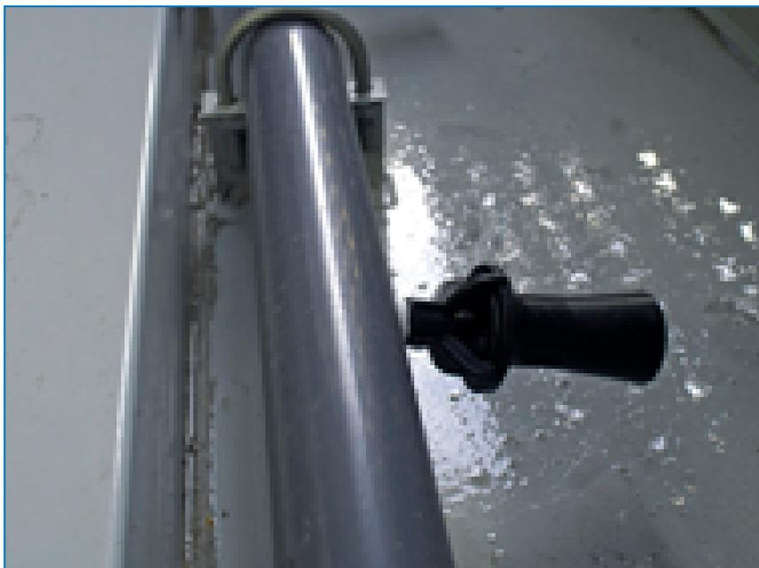
Система трубопровода очистителя поддона **усиливает циркуляцию и перемешивание воды** в бассейне и разработана для использования в комбинации с [системой](#) фильтрации. Эта система:
