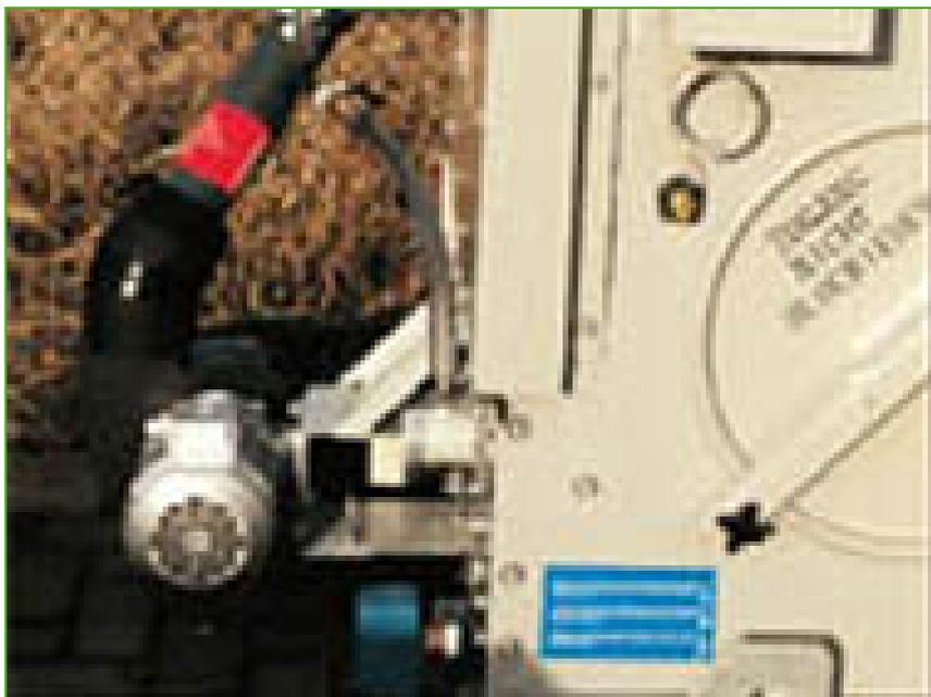
Если вентиляторы заключены в шумоглушители, переместите насос циркуляции воды **на сторону подсоединения**, чтобы улучшить доступ для осмотра и обслуживания.
